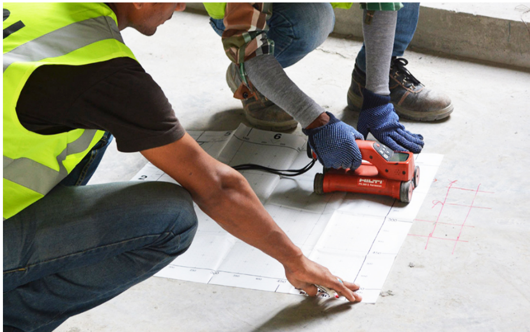
รูปแสดง scan หาดำแหน่งของสวดอัดแรง
